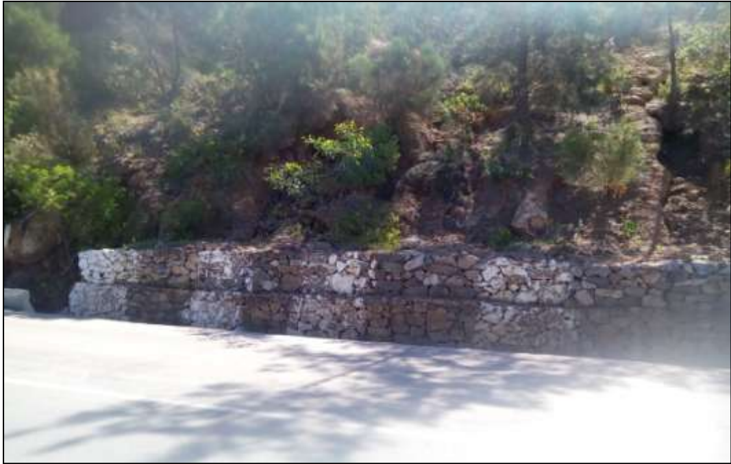
Figure V.16. Partie aval du talus stabilisé par gabionnage
