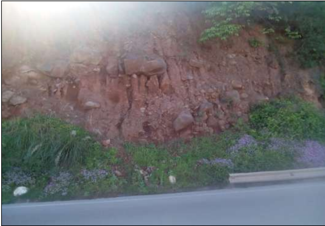
Figure II.8. Blocs de microdiorite emboîtés dans une matrice limoneuse au PK 39+00
