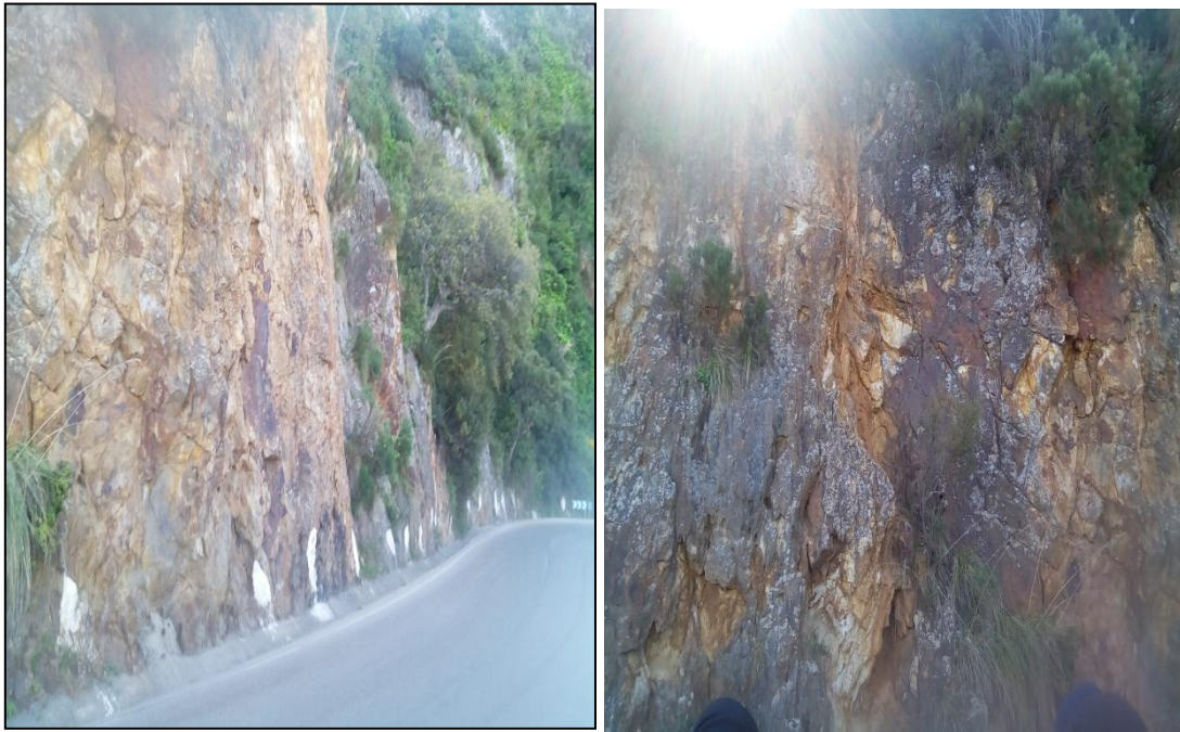
Figure IV.6. Massif fracturé avec de nombreuses fissures y compris les miroirs de failles
