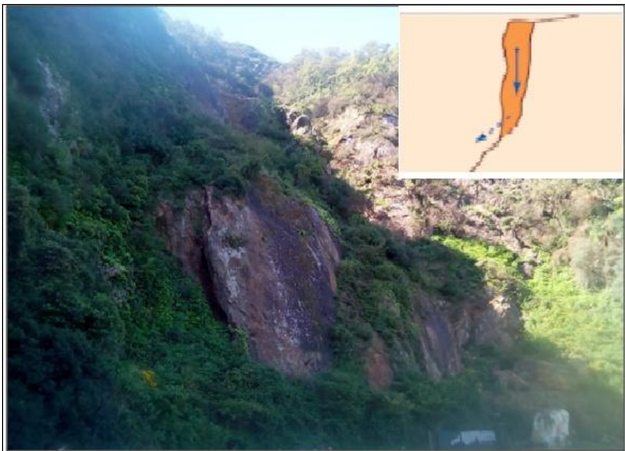
Figure IV.8. Rupture de pied de colonne
