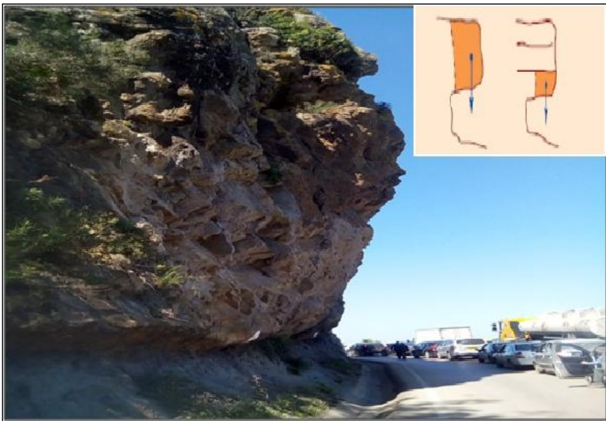
Figure IV.14. Rupture de surplomb ou de dalle en toit
